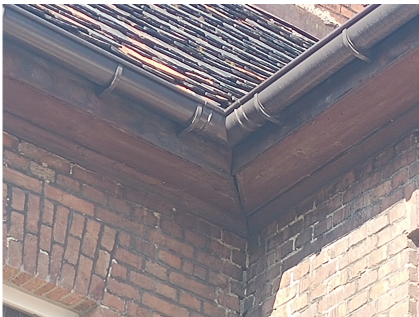
Fot.13 Przykład uszkodzenia podbitki dachu.
