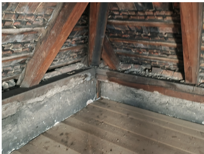
Fot. 13 Zawilgocone belki podwalinowe.
