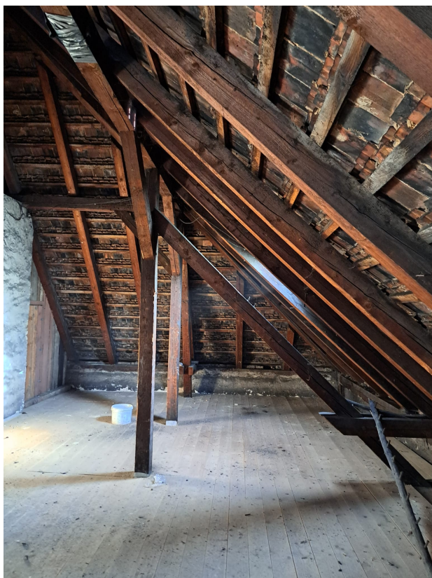
Fot. 9 Fragment więźby dachowej.
