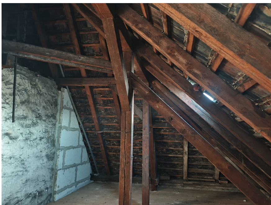
Fot.10 Fragment partii koszowej konstrukcji dachu, wtórne wypełnienia zaprawą.
