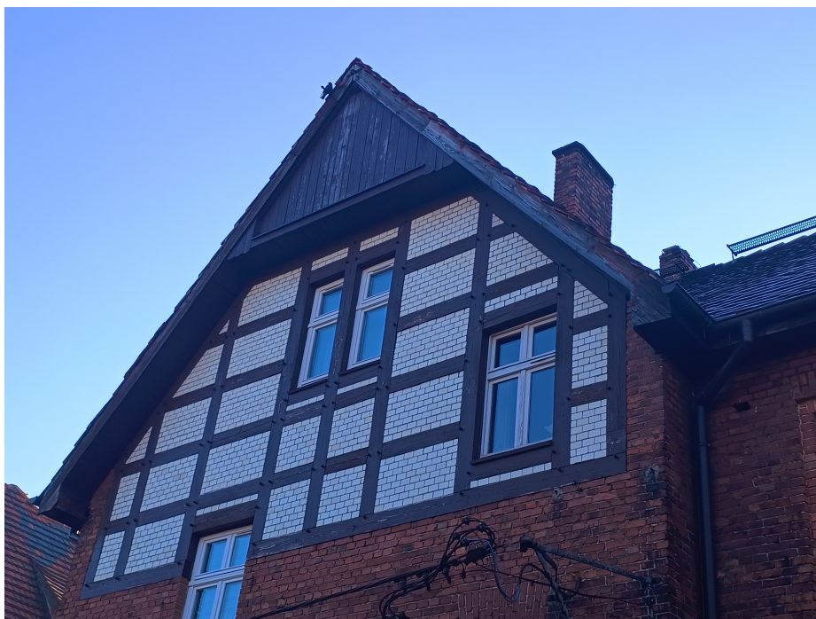
Fot. nr 5 Fragment elewacji od strony podwórza z murem pruskim.
