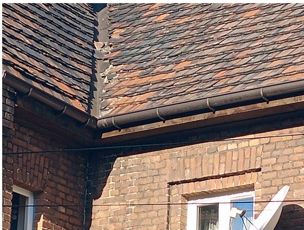
Obluzowane fragmenty pokrycia dachowego.
