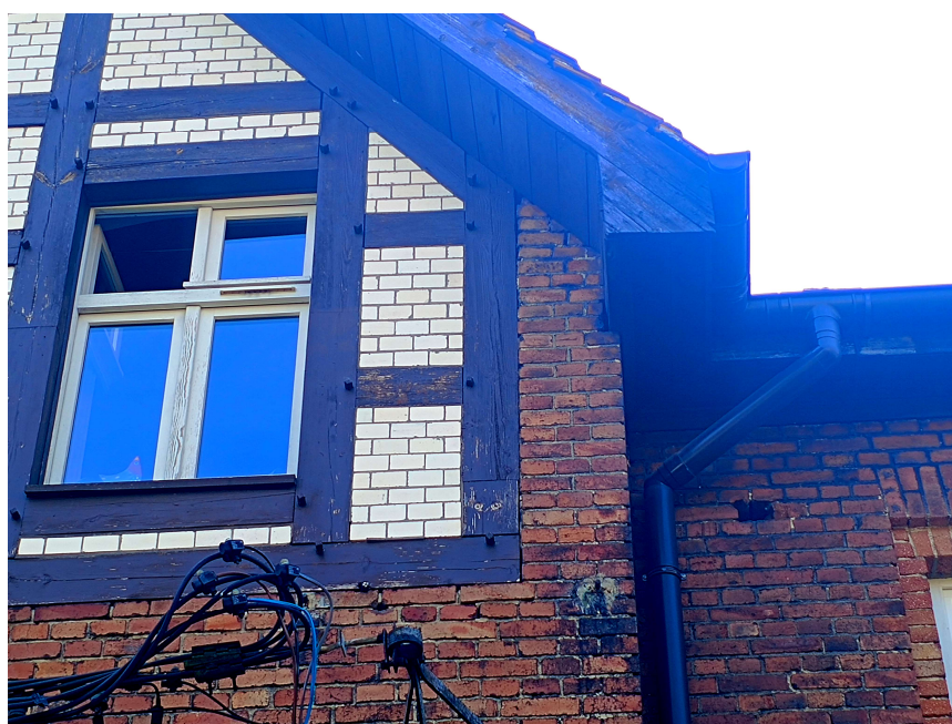
Fot. 18 Uszkodzenia czołowych listew szczytu i podbitki.
