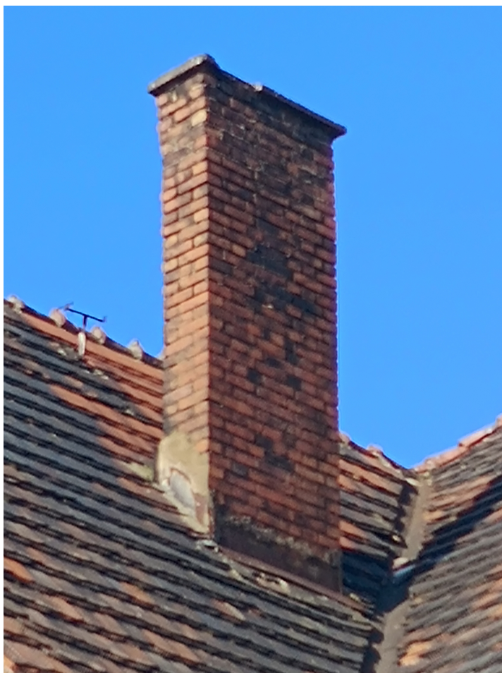
Wypaczony komin, obluzowane cegły, uszkodzona czapa kominiarska, uszkodzone obróbki blacharskie.
