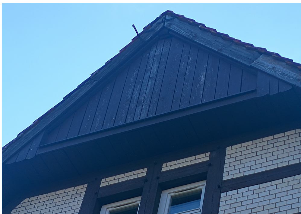
Wypełnienie listwami szczytu ryzalitu.
