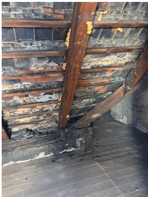
Fot.10 Fragment partii koszowej konstrukcji dachu, wtórne wypełnienia zaprawą.
