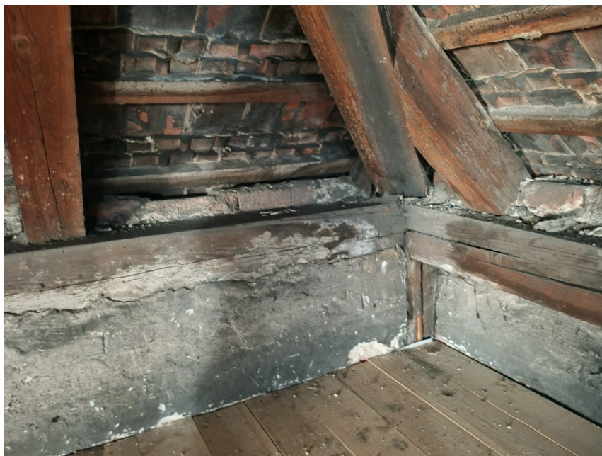
Fot.12 Zawilgocone belki podwalinowe.
