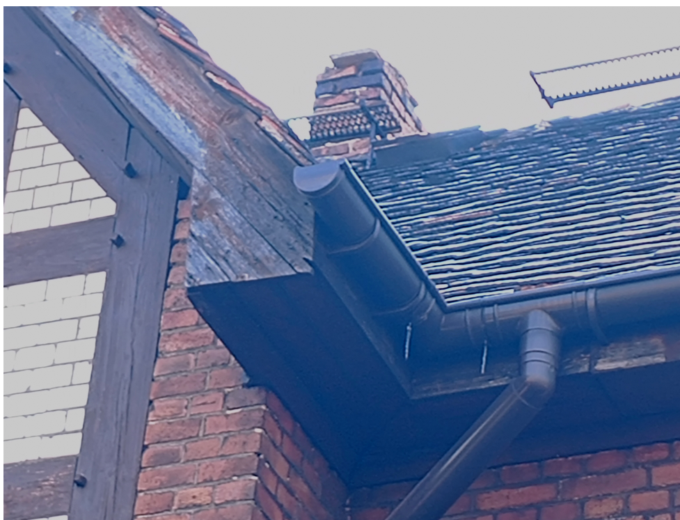
Odbarwione deskowanie, uszkodzony komin.
