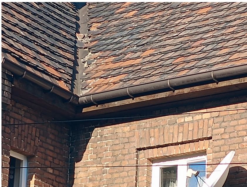
Fot. 8 Niejednorodne pokrycie dachowe, obluzowane elementy dachówek zalegające na krokwi koszwowej.
