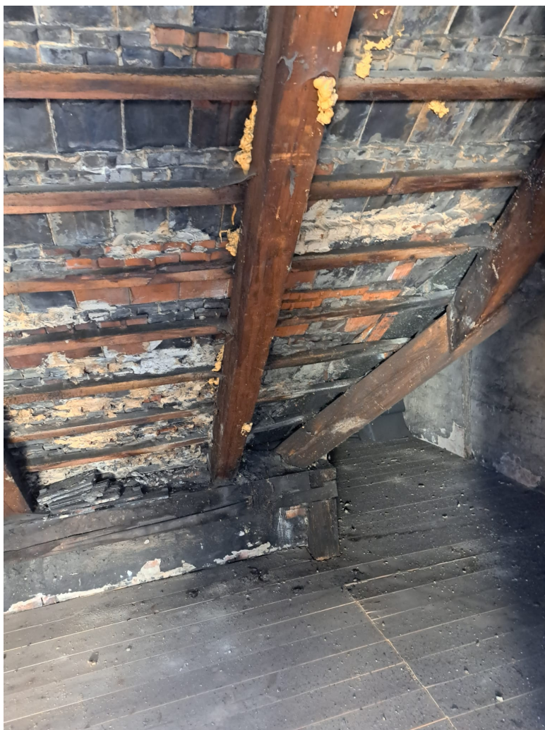
Fragment koszowy konstrukcji dachu.
