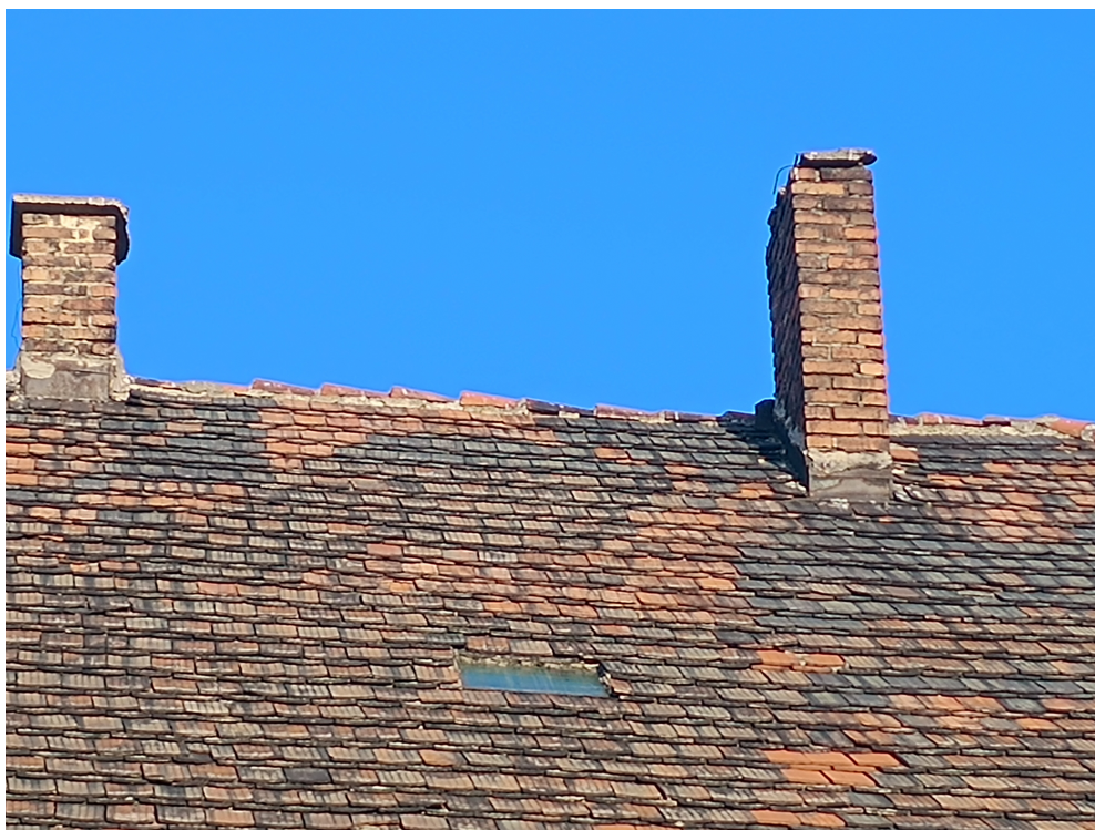
Pokrycie dachowe po wcześniejszych pracach zabezpieczających, uszkodzone, czapy kominowe.
